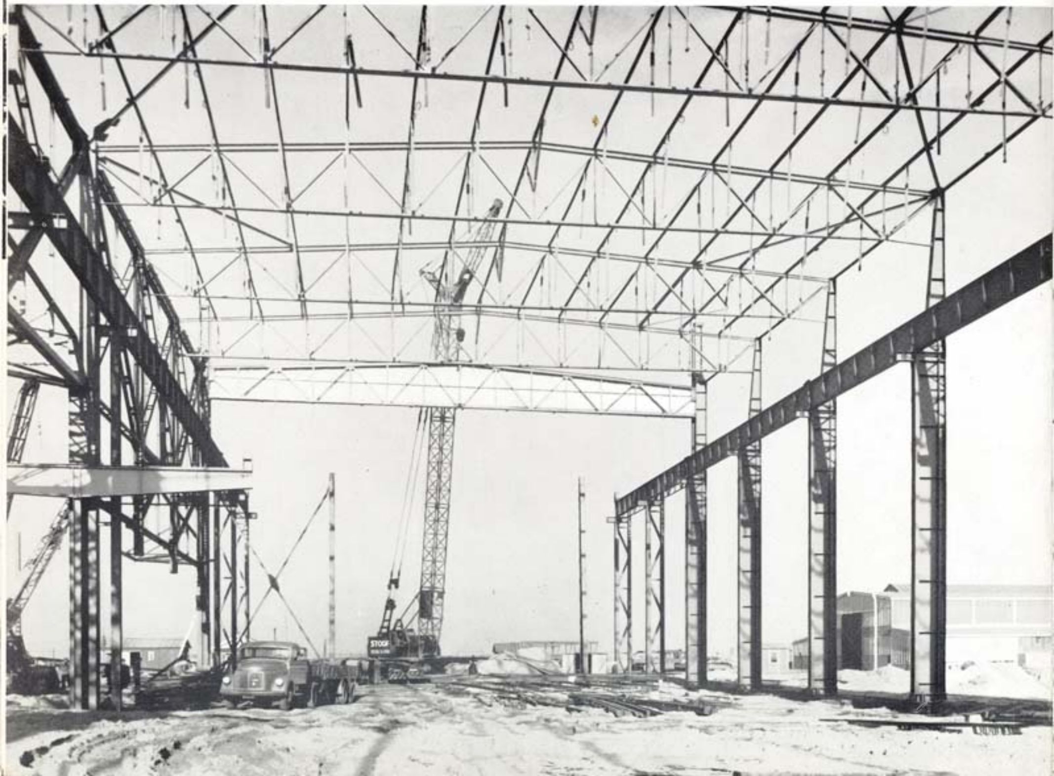
Montage van een loods in staalconstructie. Montage d'un hangar métallique. Erecting a steel-frames shed. Schuppenbau aus Stahlkonstruktion.
